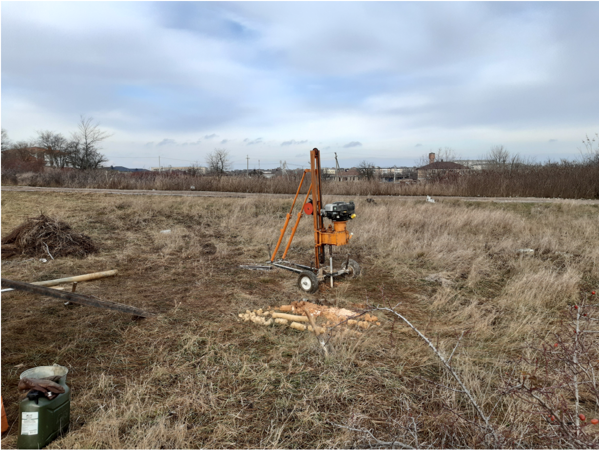
Фото 1. Буровые работы на скважине №1
