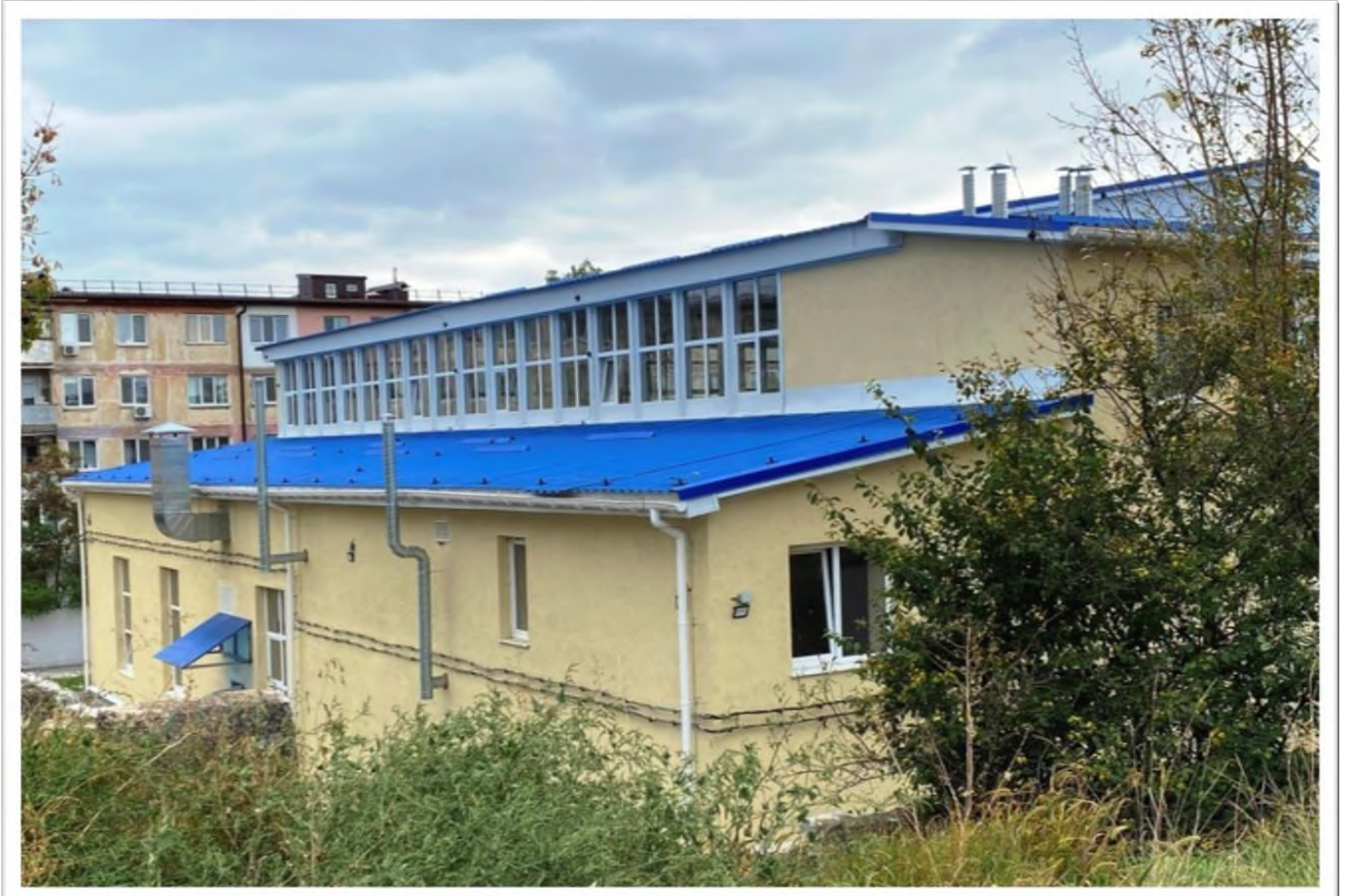
Фото 2022 г. после капитального ремонта
